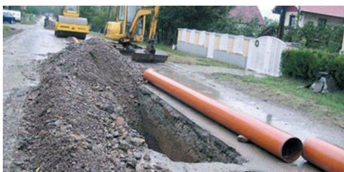
Izgradnja kanalizacije
