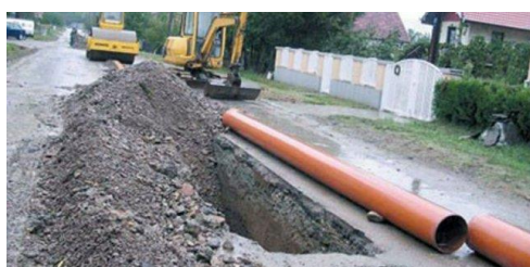
Izgradnja kanalizacije
