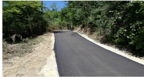
Izgradnja nerazvrstanih cesta
