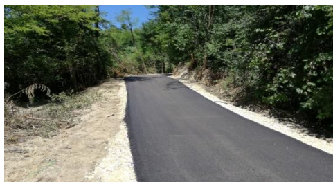
Izgradnja nerazvrstanih cesta
